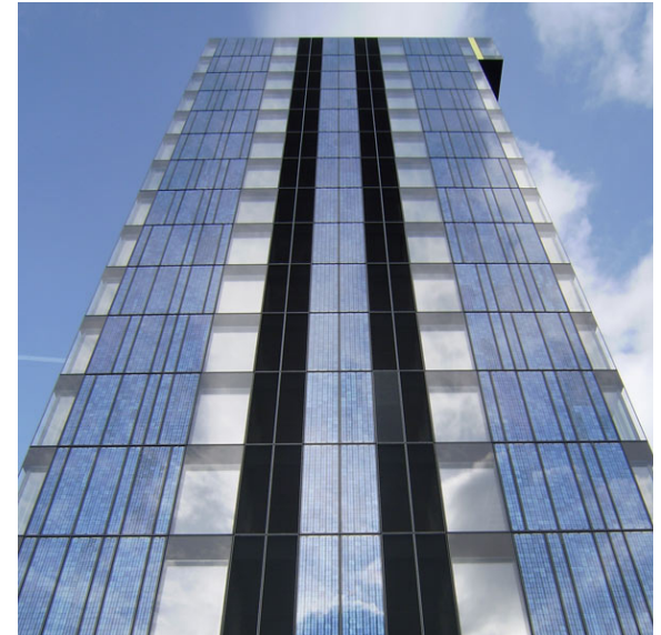
A linzi Power Tower, teljes déli homlokzatán PV panelekkel burkolt, első osztrák passzív irodaház
