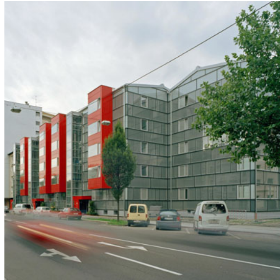
Egy, az ötvenes években betonból épült lakóház felújítása passzívház szintre. Linz 2006
