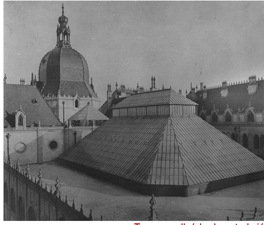
Terasz mellvéd rekonstrukció
