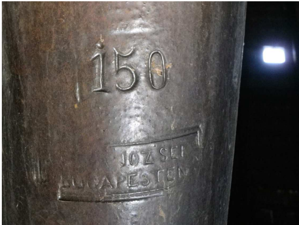
PA01 A vegytani beépített szekrény („vegykonyha”) agyag szellőzőcsöve a K-i szárny padlásterében
