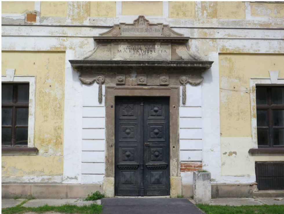
4.3. A K-i szárny főkapuja a késő barokk kőkerettel
