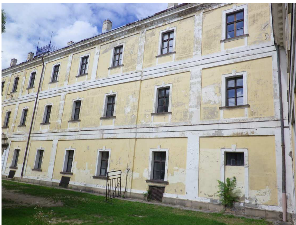
4.2. A K-i szárny Ny-i homlokzata, jobb oldali szakasz
