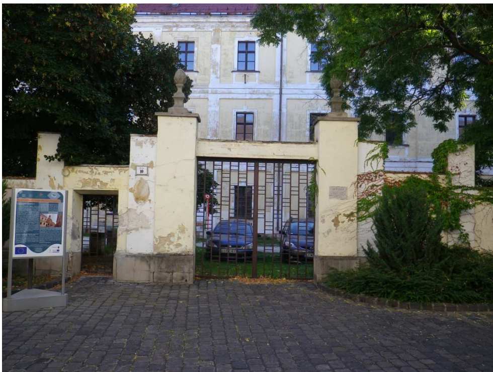
4.15. Az utcai kerítésfal, középső kapuk
