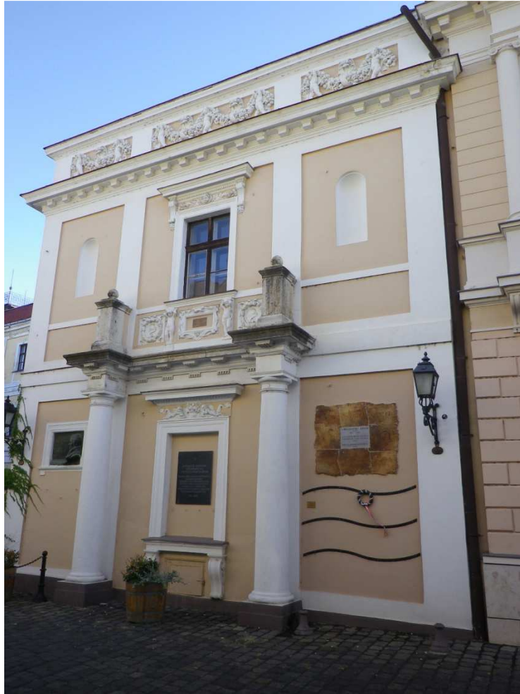
4.11. A D-i szárny Ny-i, utcai homlokzata
