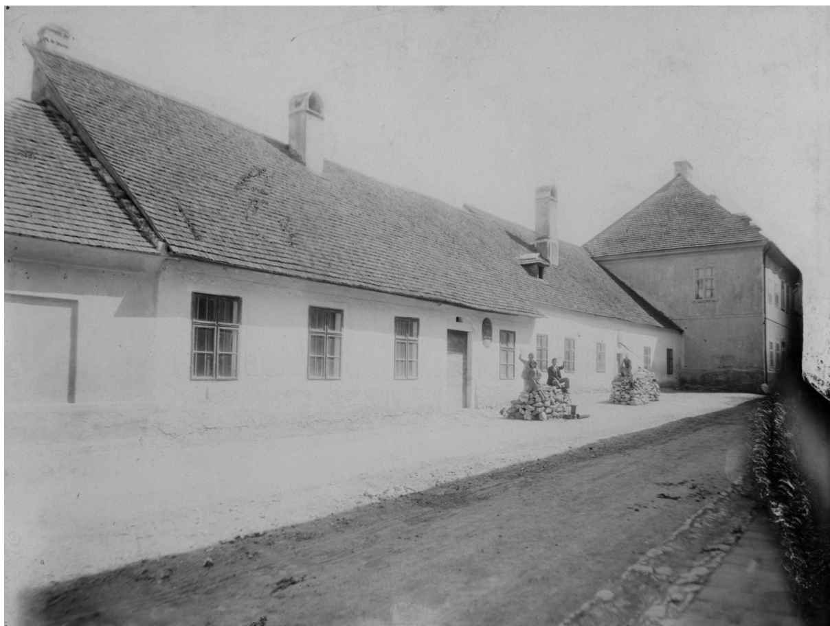
7.9. A gimnáziummal dél felől szomszédos épületek 1895 előtt. LDM Fotótár 7647
