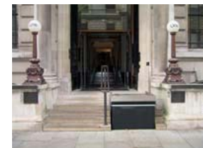
lépcsőbe rejtett személyemelő plató (forrás: Sesame Access)
