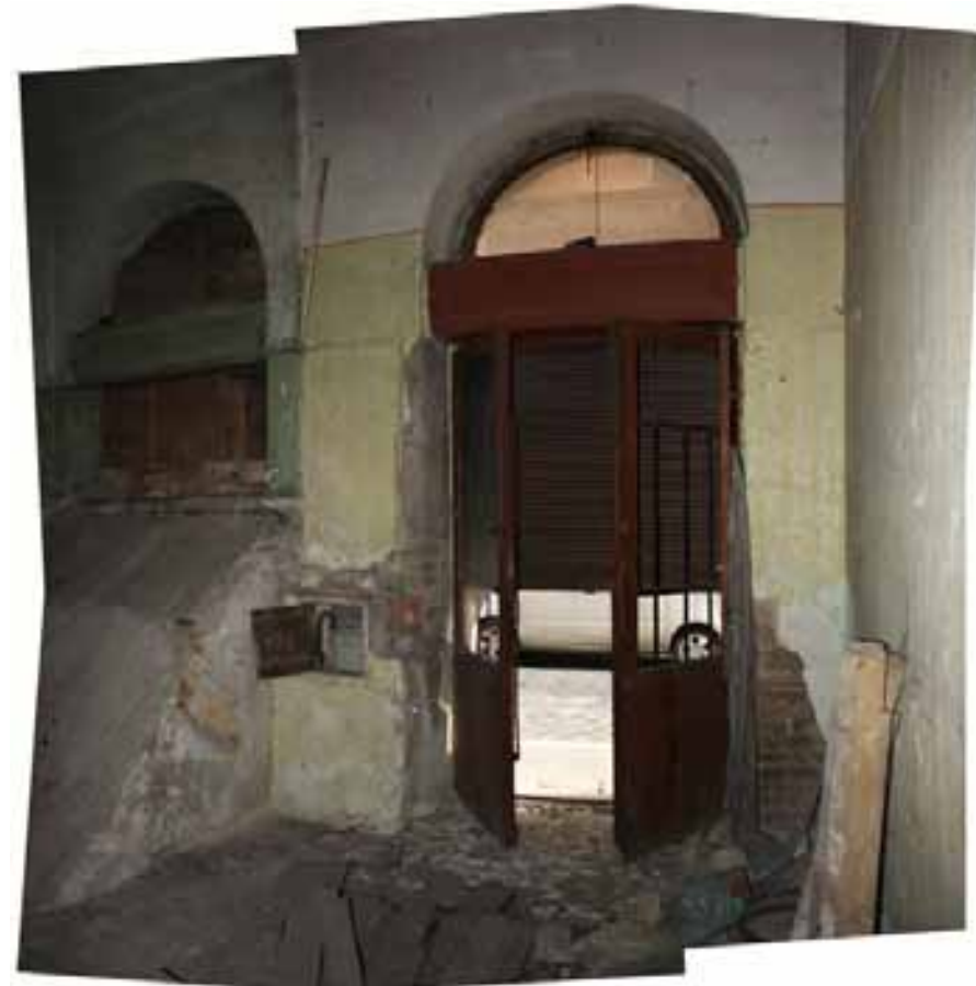
meglévő nyílászárók felújítása, cseréje
