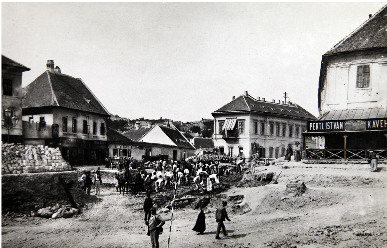
A Szarvas tér szabályozása ( a villamos vasút építéséhez a talajszint lesüllyesztése), 1894; Klösz György felvétele A kép jobb oldalán látható a Szarvas-ház eredeti állapotában.
