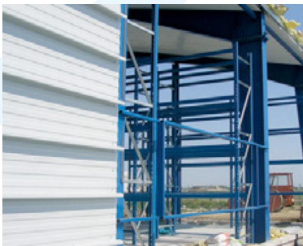
Acél vázszerkezethez szerkezeti falkazettás burkolati rendszer
