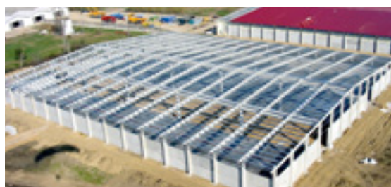
Törökszentmiklós, Vasbetonvázaz terménytárolók
