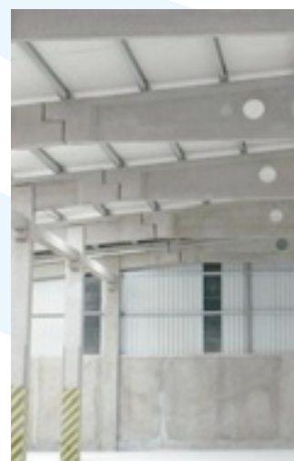
Előregyártott vasbeton vázszerkezetes acélszerkezetes tető- és falburkolattal
