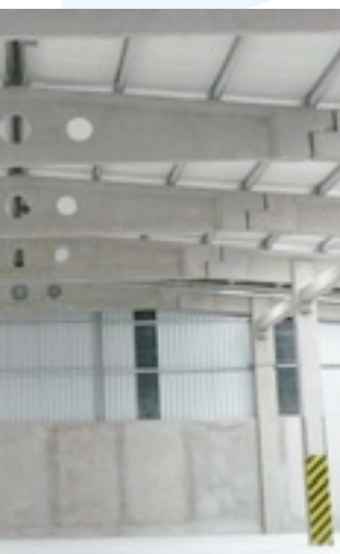
Etétfallal, könnyű ttal (Z-szelemen és trapézlemez)
