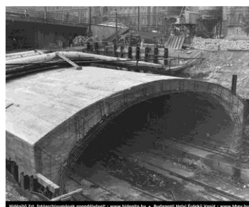
A HÉV-alagút szelvénykeresztmetszete, fotó az építésről (Hídépítő Zrt. fotóarchívuma)
