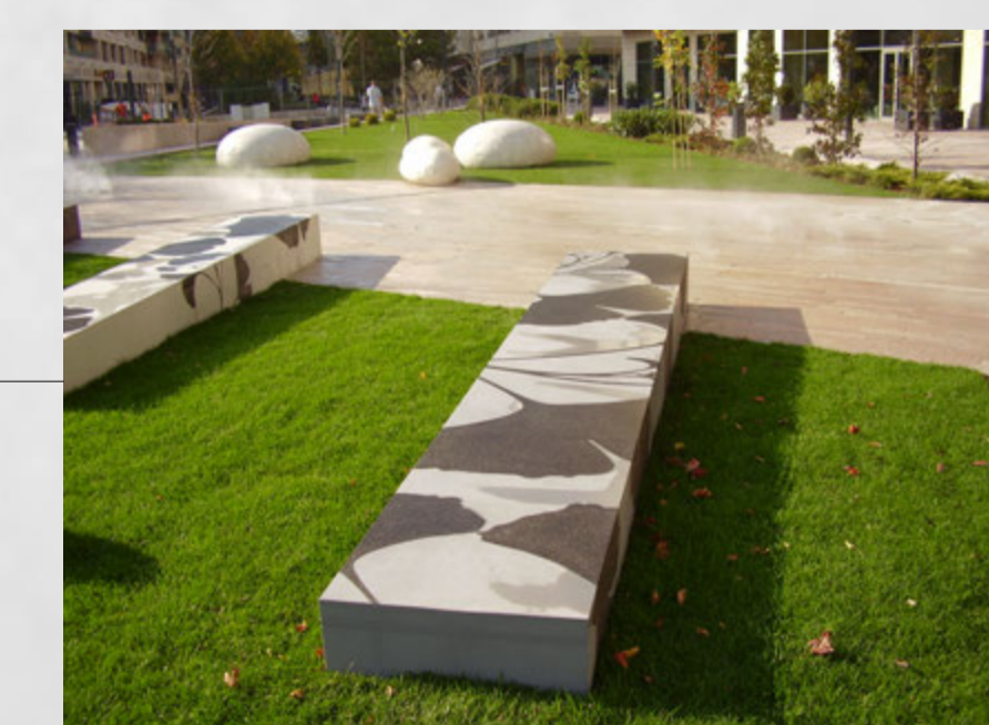
Monolit beton ülőpad egyedi kialakítású látszóbeton felülettel (környező fák levélmintáival)
