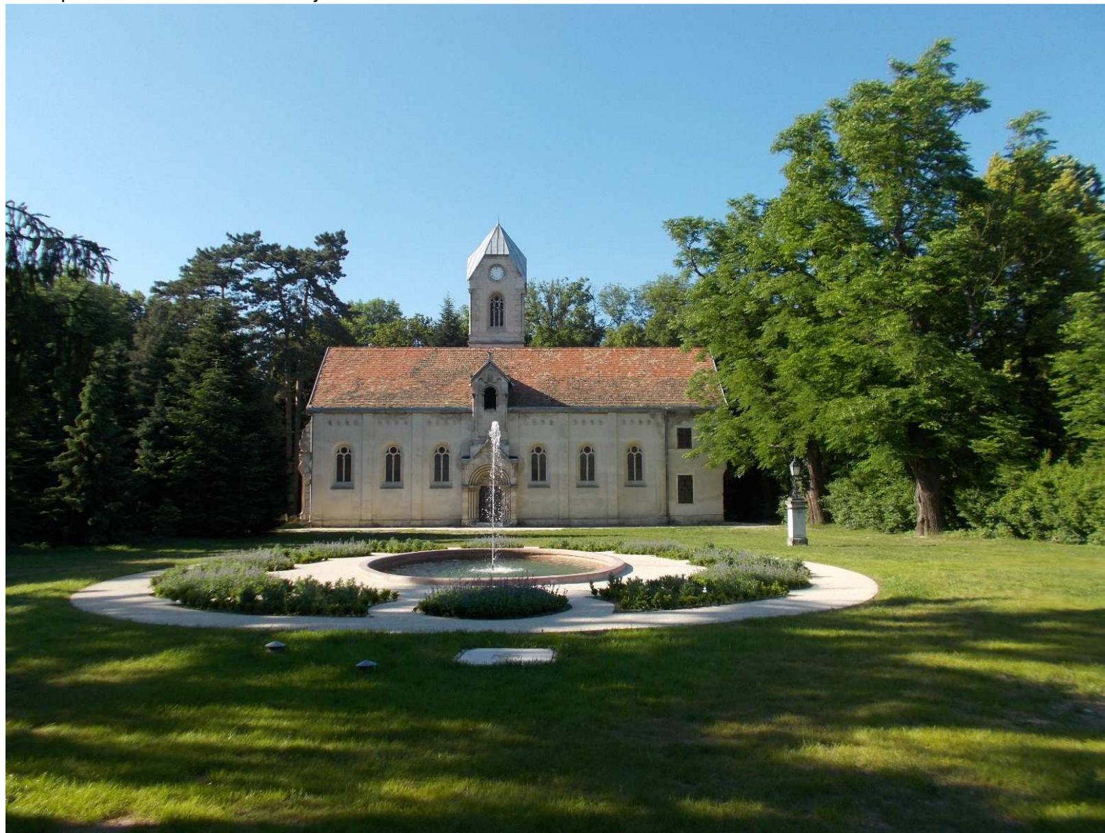
10. Kápolna udvari medence a felújítás után
