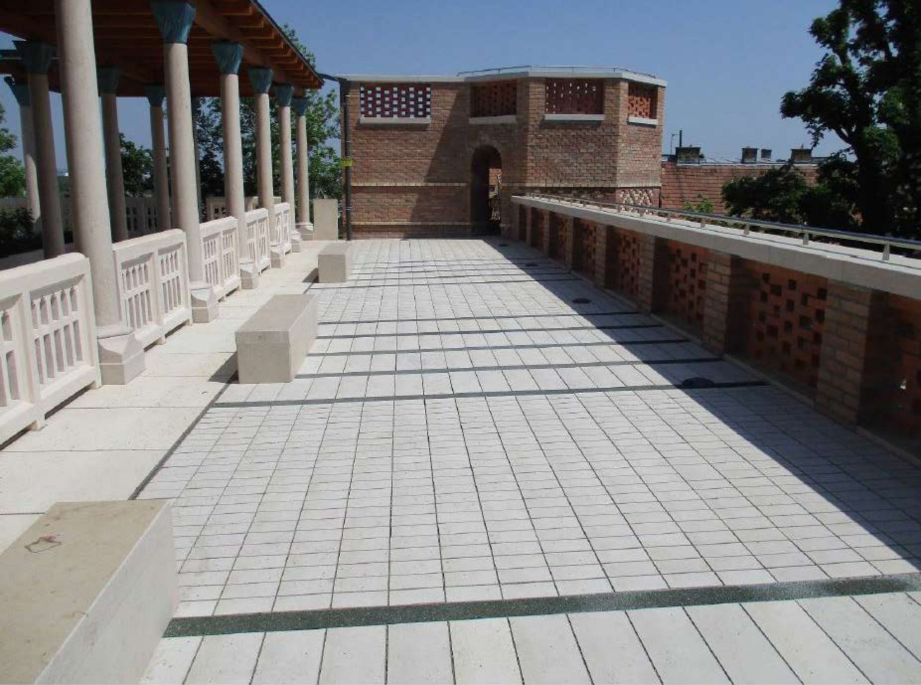
DÉLI TERASZ - BURKOLAT ARCHITEKTÚRA
