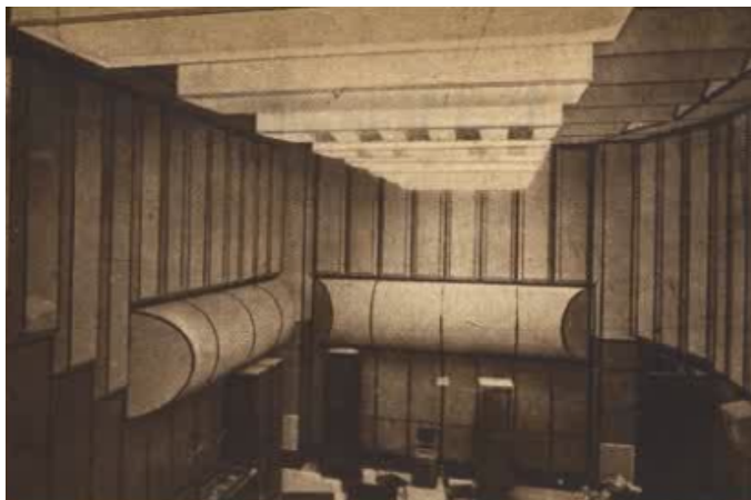
3. ábra: A 14-es stúdió akusztikai kiképzése és világítása Magyar Rádió, VI. évf./41. sz., 1950. okt. 13.
