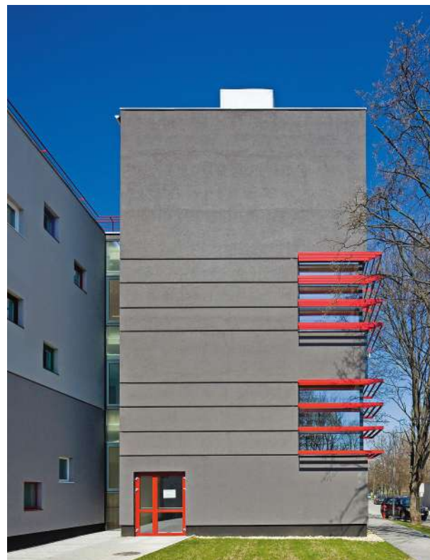
Csillagpont Kórház / Miskolc
