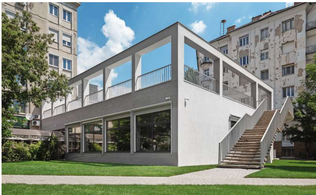
Bányati + Hartvig Építész Iroda épülete (Az Év Kömveztettudatos Irodája 2021)
